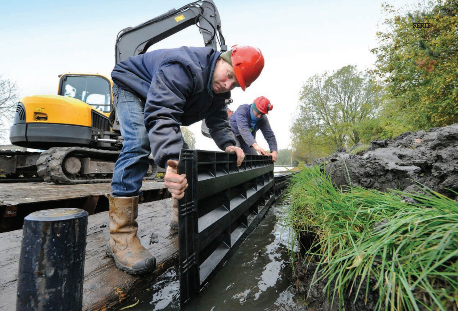
Het plaatsen van een beschoeiingsschot van Lankhorst Sneek. Het materiaal kan gemakkelijk in elkaar worden geklikt, uit elkaar worden gehaald en worden hergebruikt.
